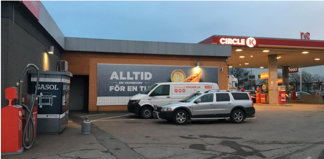
Figur 2. Utvändigt förvaring i avsett gasol-skåp.
